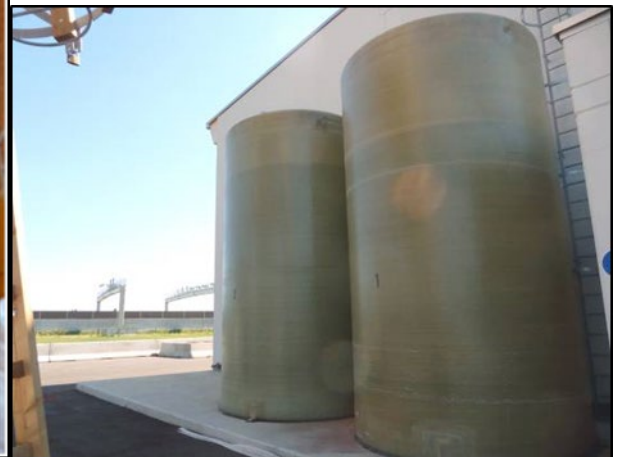
Abbildung 4 - Salzhalle Innenraum und Soletanks
