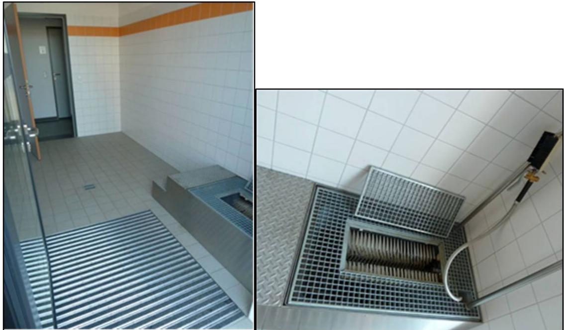
**Abbildung 1 – Stiefelwaschraum mit Waschanlage**
