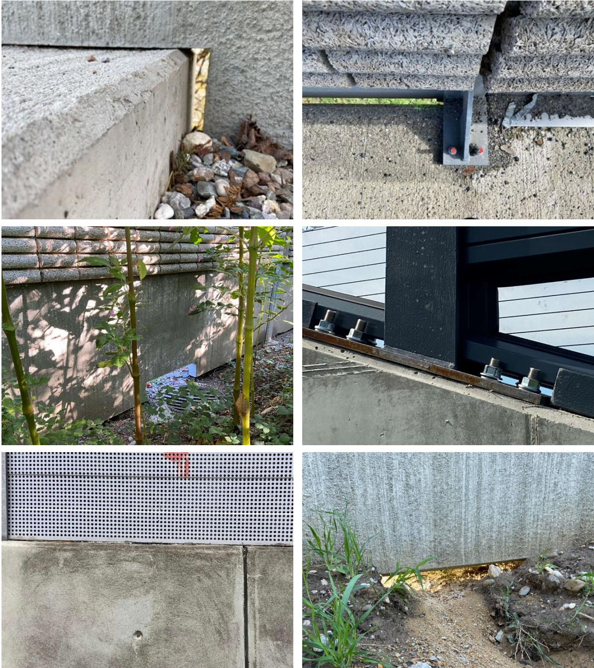
Abbildung 6: Optische Auffälligkeiten der Kategorie 3, da ein oder mehrere größere Löcher mit Durchsicht vorhanden sind.
