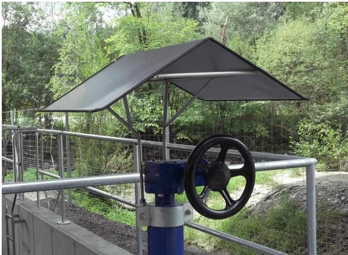
Abb. Hochzug Verlängerungsgestänge – Betätigung Klappe mit Handrad und Schutzdach
