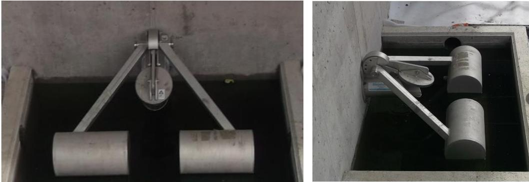
Abb: mechanisch wirkende Verschlüsse
