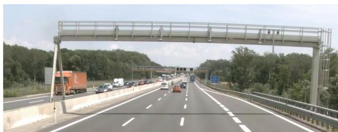
**Abbildung 3: Pendelstützenkonstruktion**
