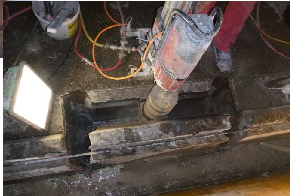
2 Ausbau Altschacht mittels 7 Kernbohrungen
