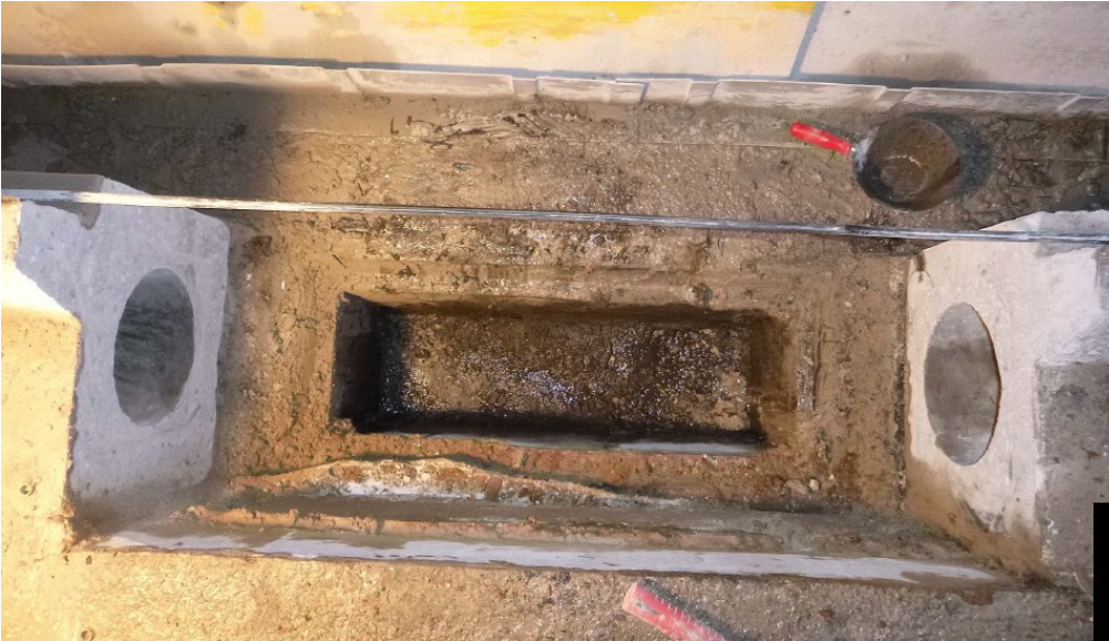
3 „Lücke“ nach Ausbau Altschacht
